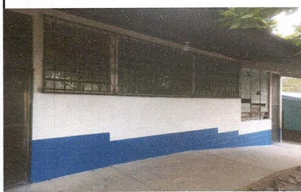
FOTO 4: BALCONES YA COLOCADOS
