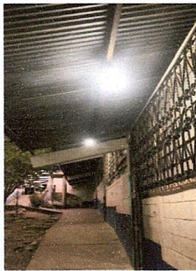
Foto 3: ENERGIA ELECTRICA EN PASILLOS YA TERMINADO
